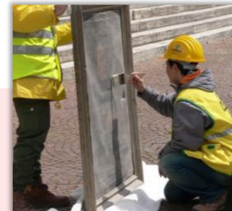
Messa in sicurezza - Opere di preconsolidamento
